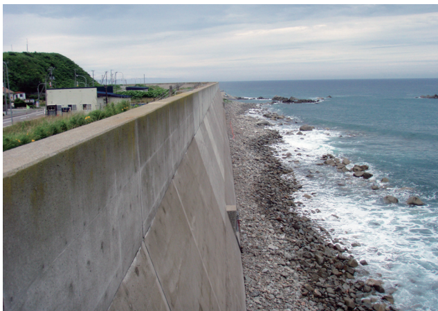
高さ11mの防潮堤
