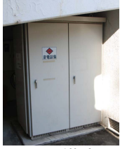
高圧受電設備(キュービクル)
