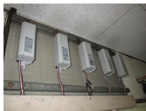
工場等の壁際に設置されている例
