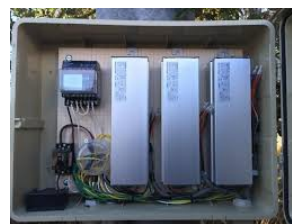
安定器BOXに収納された安定器
