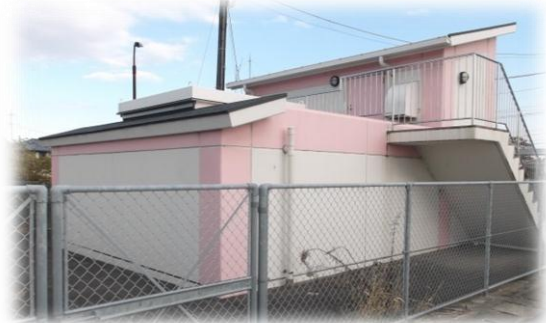
長原真空ステーション
