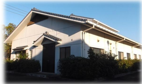
北川向地区污水处理場
