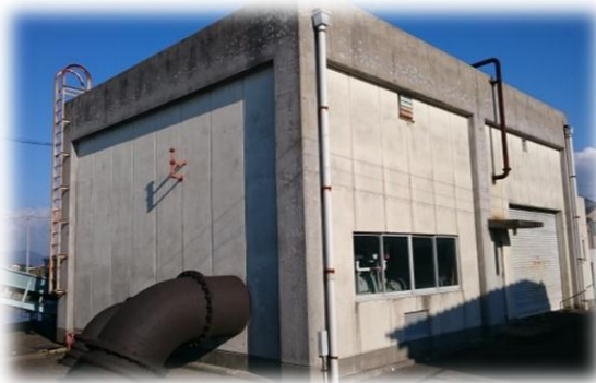
豊岡排水機場
