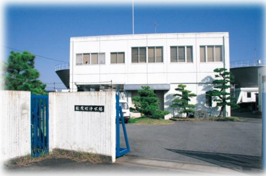
松茂町浄水場
