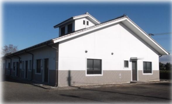
中喜来地区污水处理場
