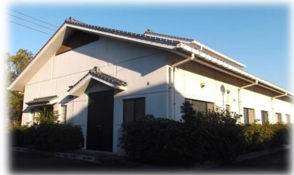
北川向地区汚水処理場
