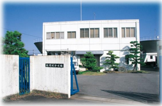
松茂町浄水場
