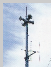
屋外子局設備
