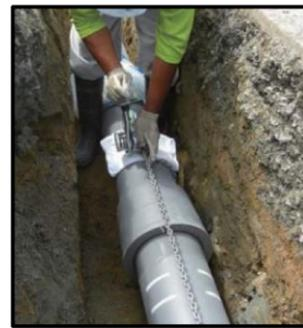
埋設管は、耐震管により地震動、液状化に強い管路とする。
