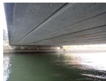
PCプレテン桁橋
