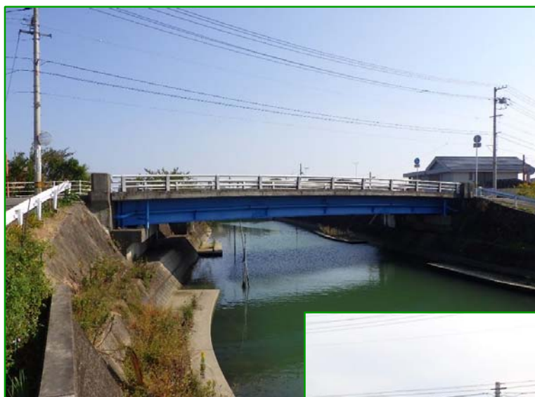
新丸須橋(昭和45年架設)
