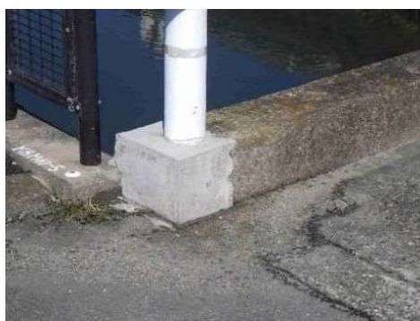
地覆の打ち替え
