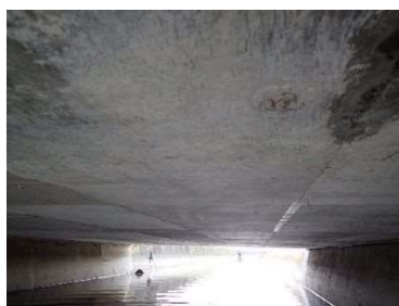
RC場所打ち床版橋
