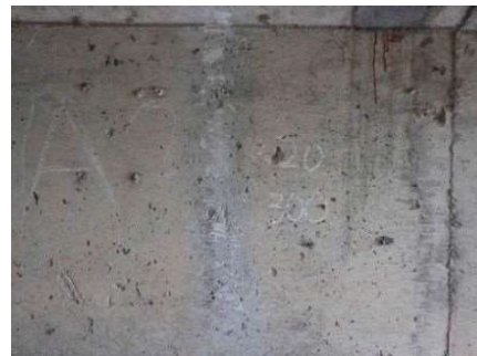
ひびわれの補修後
