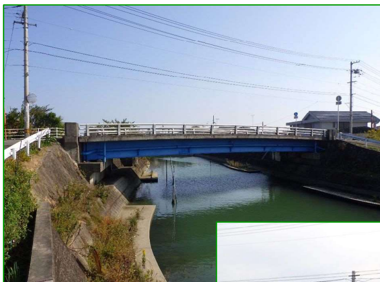
新丸須橋(昭和45年架設)
