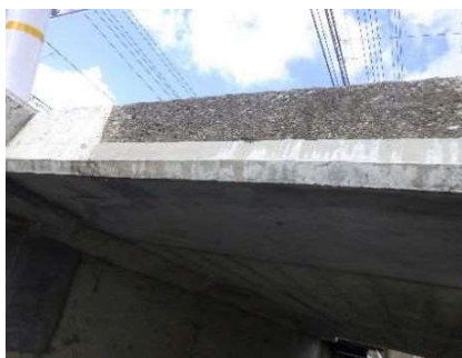
剥離・鉄筋露出の補修後
