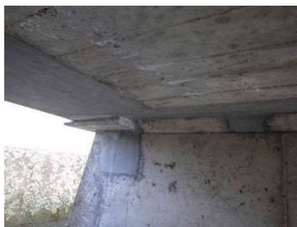
剥離・鉄筋露出の補修後
