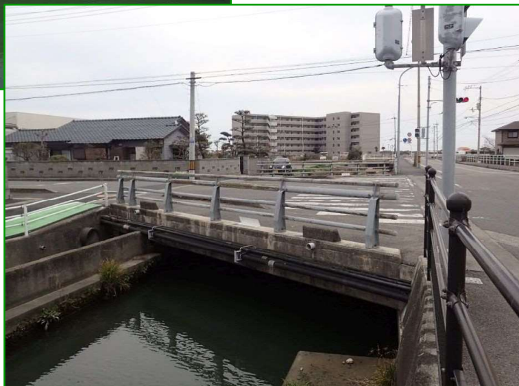
桜橋(平成4年架設)
