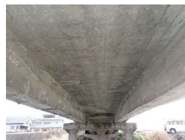
RC場所打ちT桁橋
