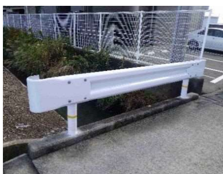
ガードレールの取り替え
