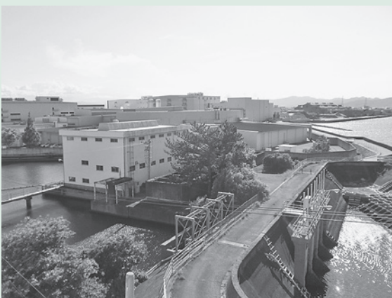
豊久排水機場
