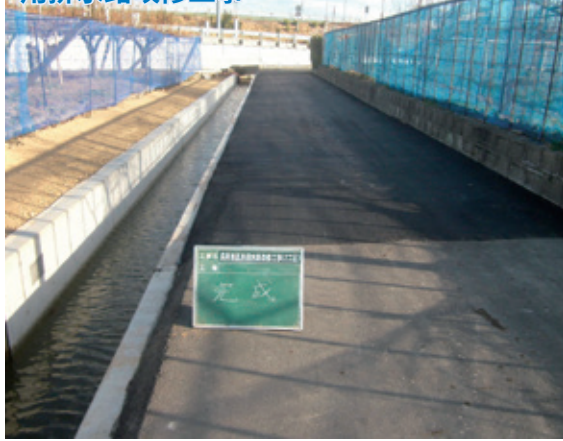
用排水路改修工事
