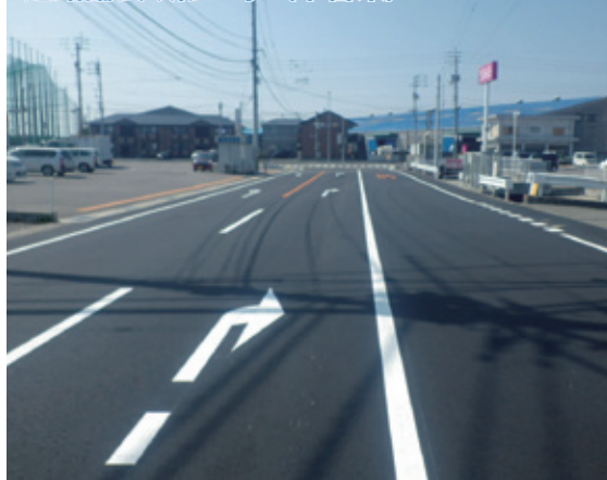
道路舗装改修工事（中喜来）
