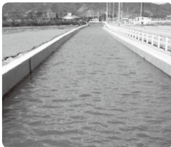
水路工事の竣工
