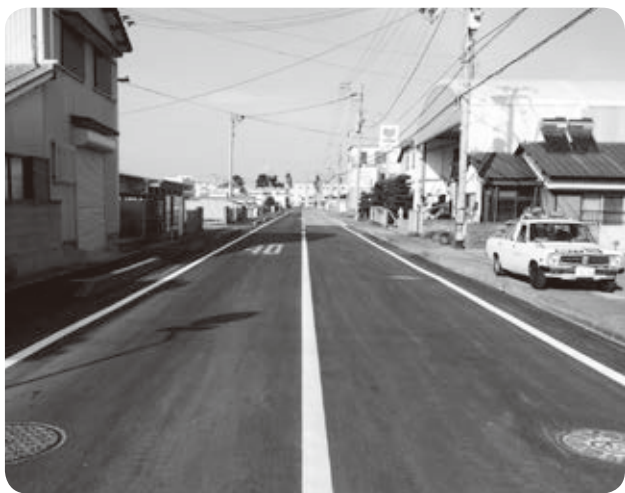
道路舗装工事の竣工
