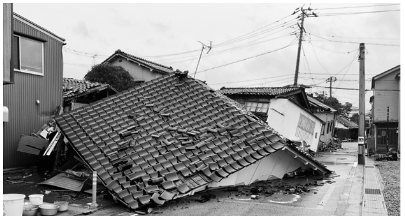
能登半島地震で倒壊した住宅
