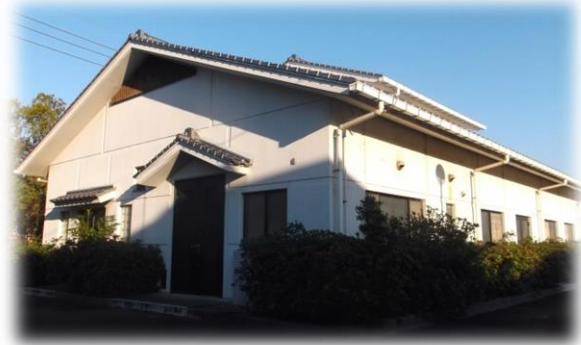
北川向地区污水处理場
