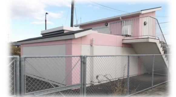
長原真空ステーション
