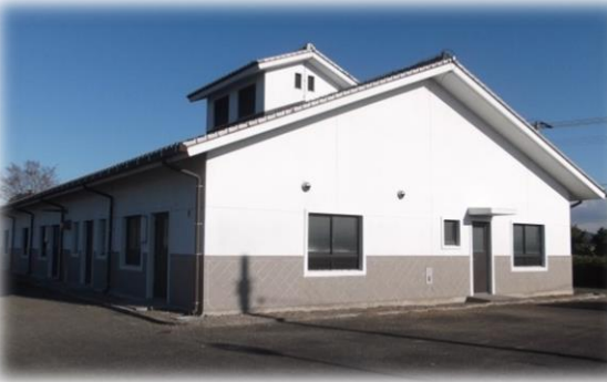
中喜来地区污水处理場
