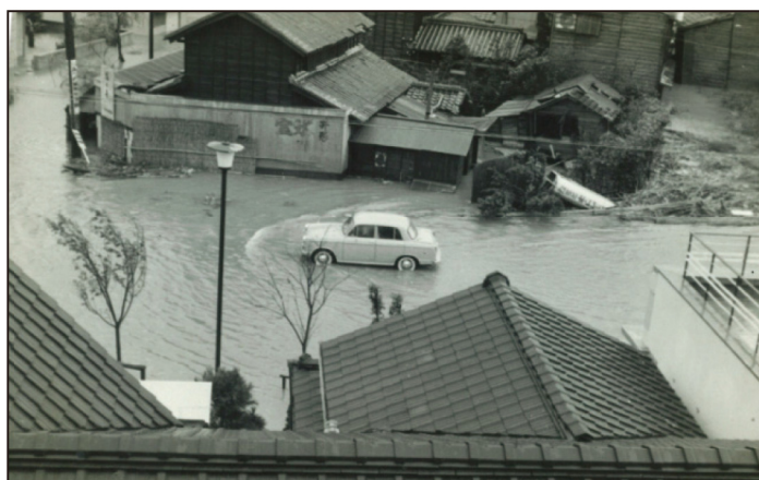
昭和 36 年 9 月 16 日 第二室戸台風による浸水被害
