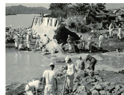
第2室戸台風により決壊した堤防(松茂町長原)
