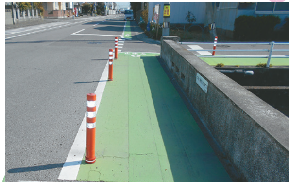
◀ 松茂小学校付近
