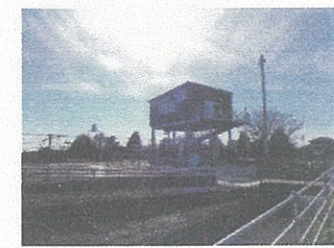
⑦ 中喜来地区津波避難タワー
