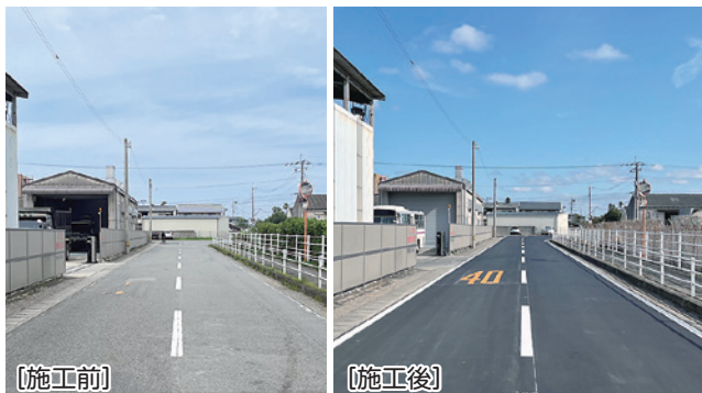
松茂15号線外1線舗装改修工事
