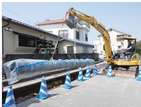
令和7年度 導・配水管布設替工事その2
