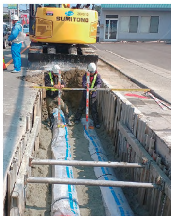
令和7年度 導・配水管布設替工事その1
